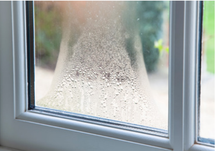
Figure 16 : Condensation sur les faces internes d'un vitrage.
